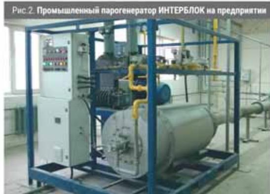
Рис.2. Промышленный парогенератор ИНТЕРБЛОК на предприятии
