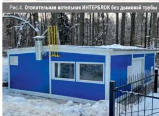
Рис.4. Отопительная котельная ИНТЕРБЛОК без дымовой трубы
